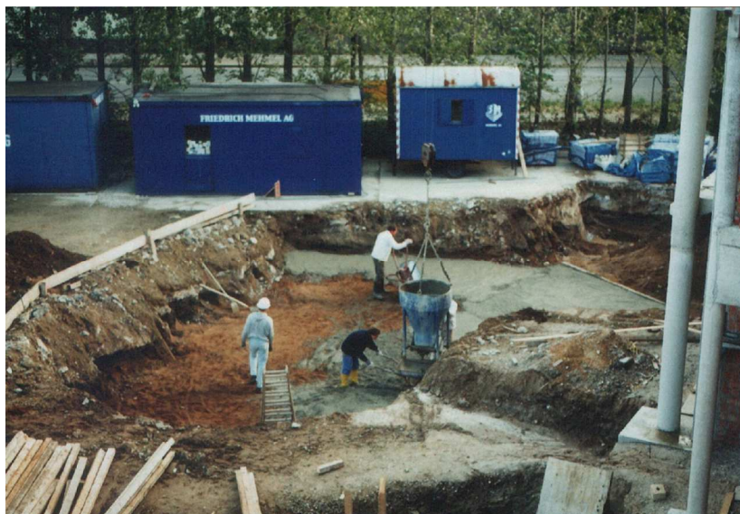
Đổ móng xây chánh điện
