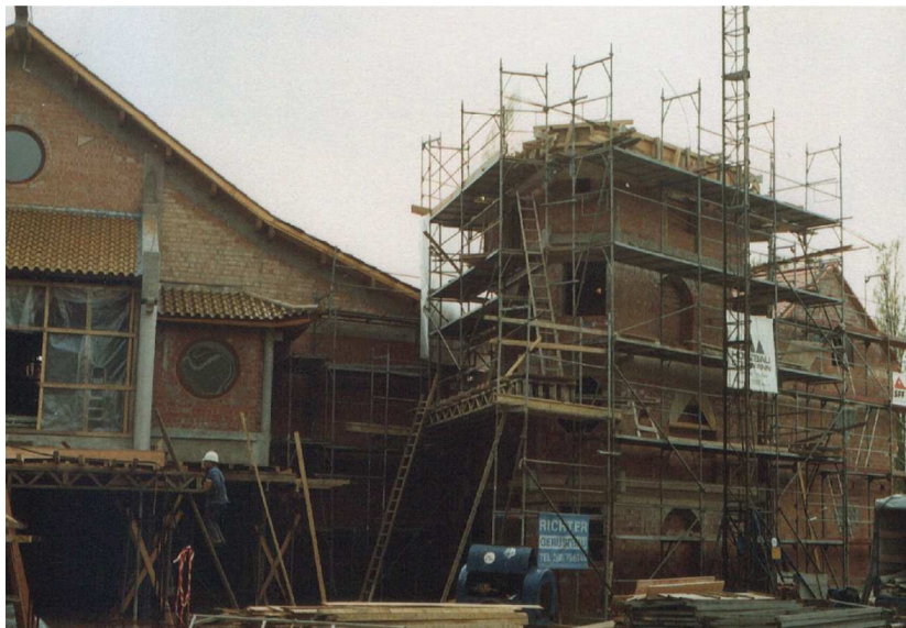
Chánh điện, Tây Đường và Bảo Tháp
