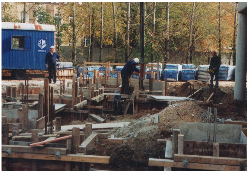
Đổ móng xây chánh điện
