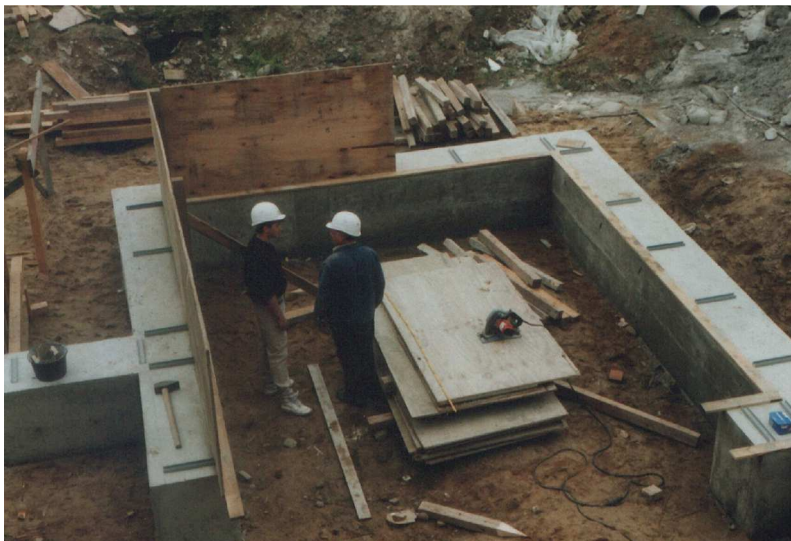
Khởi công xây dựng Đông Đường 1989
