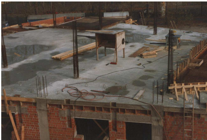
Đổ bê tông sàn chánh điện 11/89
